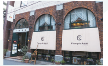
赤レンガの壁に半円窓が並び、ベルギーの街角を思わせる佇まい。神田の路地に静かに溶け込んでいる
