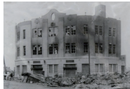
関東大震災でも倒壊しなかったコンクリートビル
